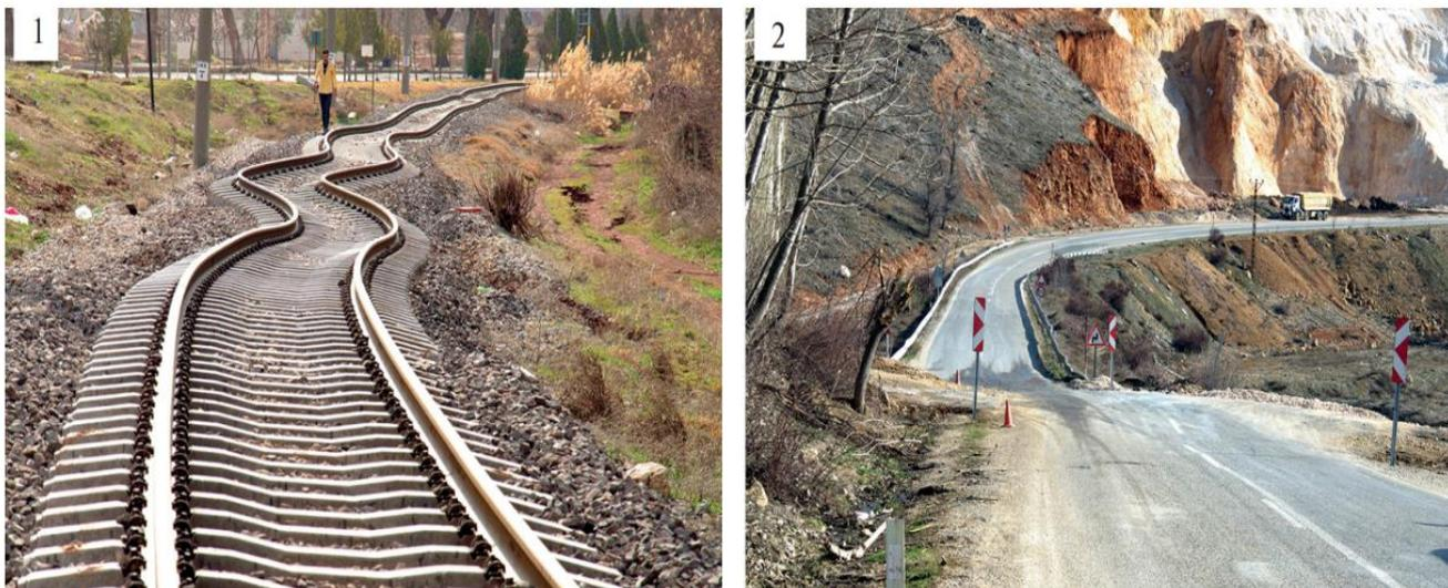
**Рис. 5.** Левосторонний сдвиг по EAFZ северо-восточнее области максимальных смещений: 1 – деформация и левосторонний сдвиг железнодорожного полотна на 5.7 м; 2 – сдвиг дорожного полотна на 5.35 м [Челик и др., 2023].
