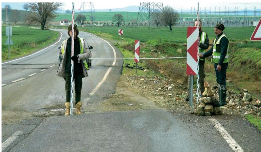
**Рис. 4.** Левосторонний сдвиг по восточной ветви DST (Трансформа Мертвого моря) возле г. Нарли (сдвиг дорожного полотна) [Челик и др., 2023].
