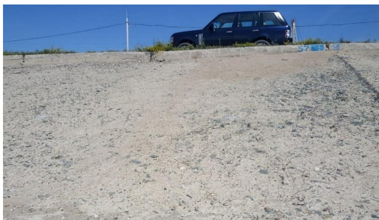
Рис. 8. Плиты крепления верхового откоса плотины Новосибирской ГЭС.
